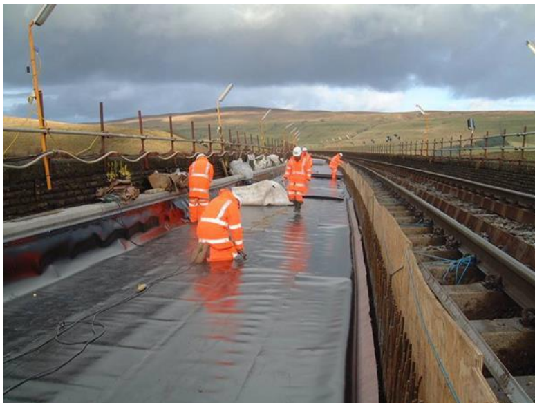
Figura 12.8.4.2.2 - Lavorazione con il 2° binario in affianco sostenuto
